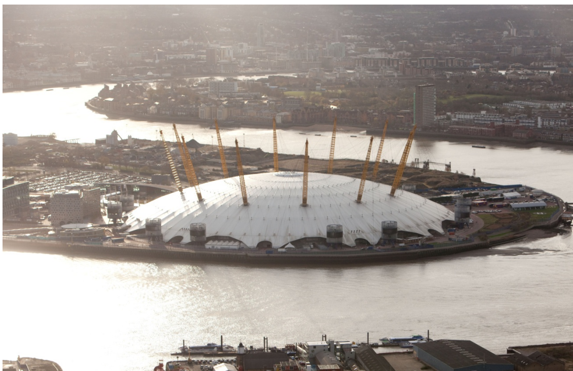
North Greenwich Arena (Fuente: London 2012)
